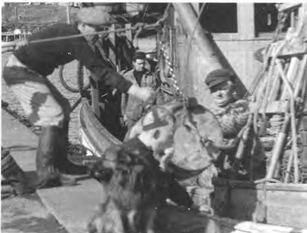
Eitt serligt amboð varð brúkt at lossa tunnur, ein leyshakari nevndur. Tað var keta við krókum ella klóm, og varð hon lögð um löggin á tunnuni. Sildarbátur á Vestarukai. (Snr. 5111F744)
