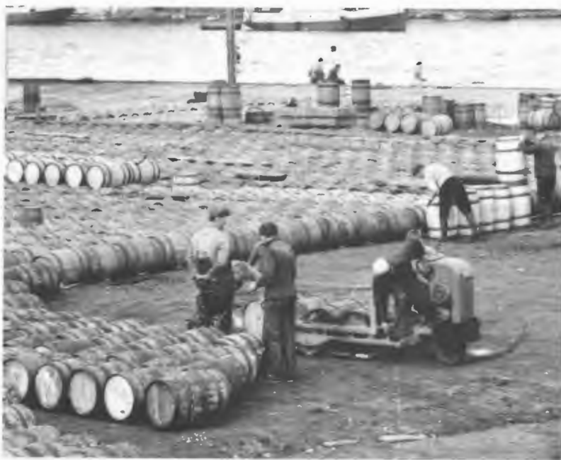
Vognurinn, ið Ólafur Guðmundsson sjálfur setti saman, riggaði væl og koyrast kundi við fleiri tunnum í senn. Slíkur vognur sást skjótt á ymsu havnarløgum í landinum í 1950-árunum. (Snr. 5111F743)
