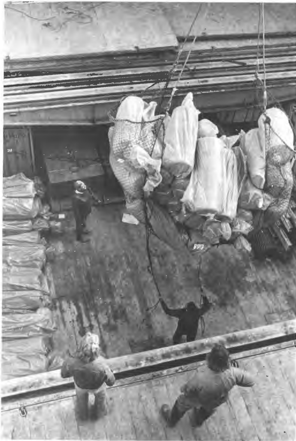
Lossinet við glasull kemur upp. Ein maður heldur í tveir endar og stýrir, soleiðis at netið kemur beint upp úr lastini. Hin maðurin er farin burturfrá. (Kalmar Lindenskov)
