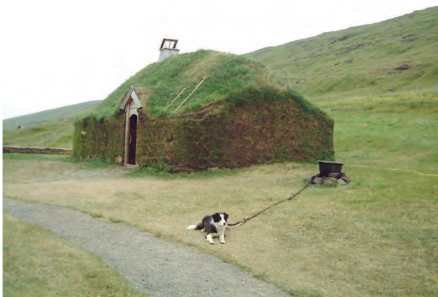
Fig. 2. Rekonstruktionsförslag till hallen som grävdes ut på Eiríkstaðir i Haukadalur 1997-1999. Denna hustyp, som hade skyddsväggar enbart av torv, var vanligast under kolonisations-tiden på Island.
