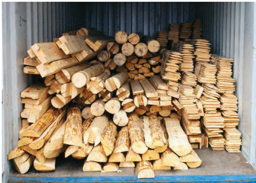
Fig. 4. Tillsnickrad virke till rekonstruktionen i Qassarsuk på plats i containern. Huset beräknas vara 10 x 5 m i innermått.
